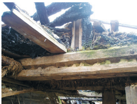
14. att. Mācītājmājas pārseguma konstruktīvais risinājums. Redzamas vietas sijā, kur bija iestiprināti apaļie koki. Foto 2005.
